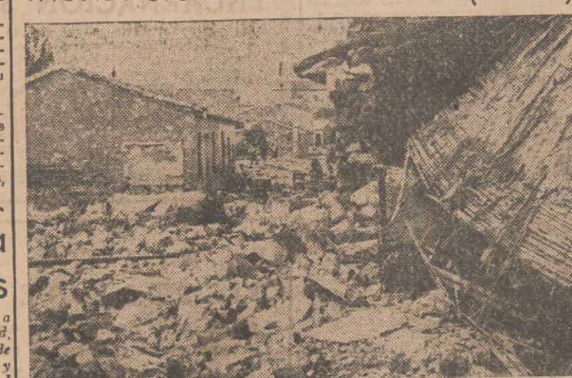
Una vista de una calle del pueblo de Santomera (Murcia), devastado días atrás por un nuevo desbordamiento del río Segura. — (Foto CIFRA).
