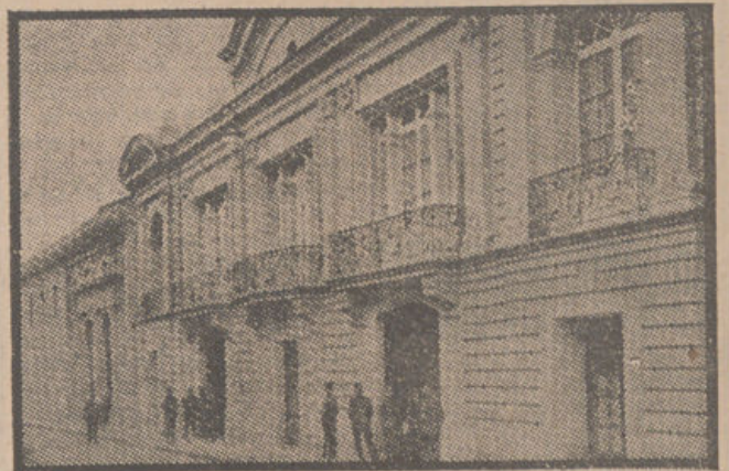
Fachada principal del Palacio presidencial de Bogotá (Colombia).
