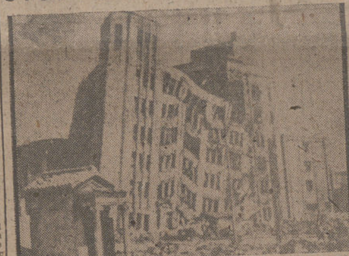
FUKUI.—Estado en que ha quedado un gran edificio de esta localidad, con motivo de los recientes terremotos. (Fot. P. A.).
