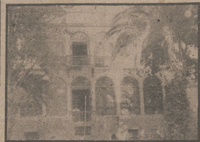
Fachada posterior del edificio de la nueva Facultad de Filosofía y Letras, ante la que se extiende un jardín para solaz de los estudiantes. Frente a la escalinata, se alza una simbólica estatua de Minerva. (Fot. SANZ).
