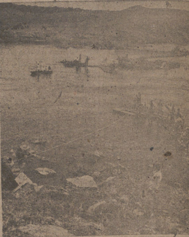
Embalse para una central hidroeléctrica de Uganda. Produce 120.000 kilovatios.
