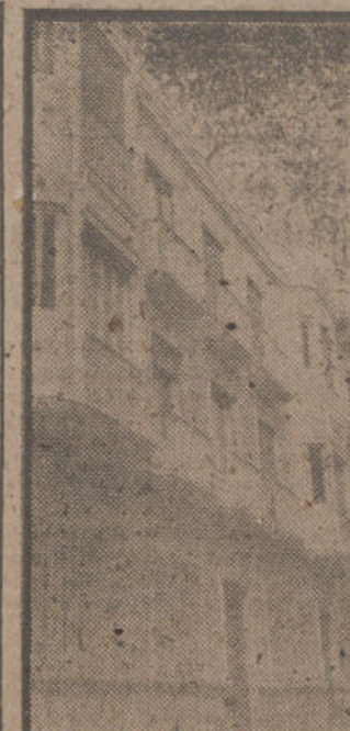
Fachada del nuevo ambulatorio de especialidades, en el Puente de Castañeda, cuya inauguración se celebrará esta mañana. (Fot. SANZ).
