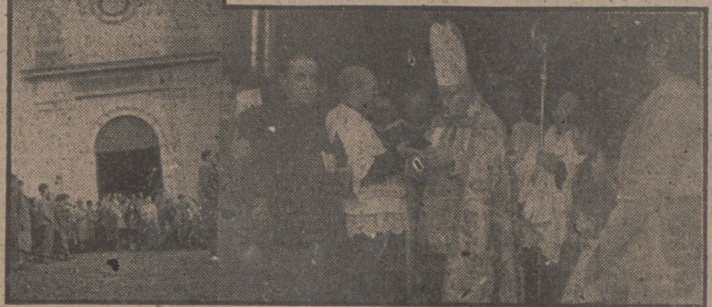
S. E. Revdmo. el señor Arzobispo, doctor Santos Olivera bendijo el domingo las nuevas Escuelas del Ave-María, construidas en la barriada de San Isidro. A la izquierda, fachada principal del nuevo centro docente. (Fot. SANZ).
