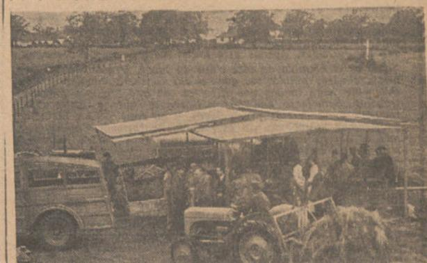
Máquina secadora de grano y torraje; se pone en condiciones de trabajo en media hora y solo necesita cuatro obreros. (Fot. CALPE).
