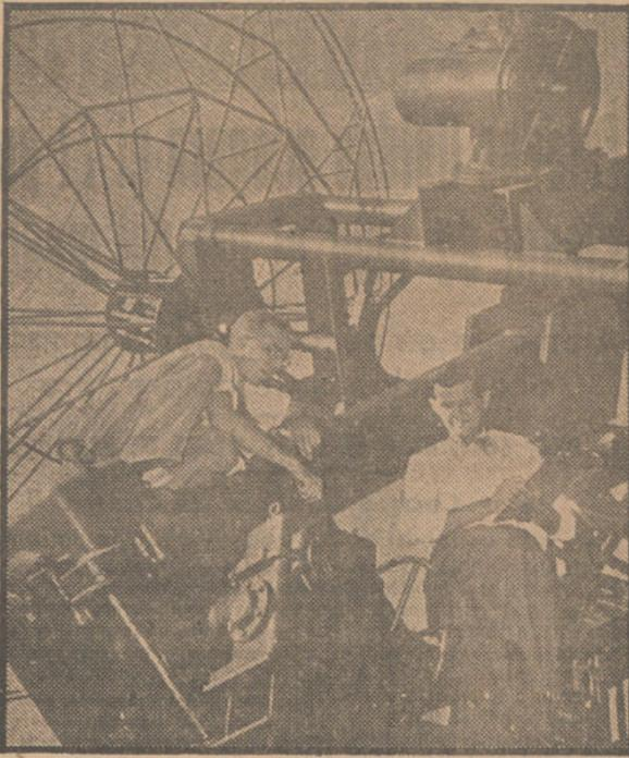
Este radio-telescopio de la Universidad norteamericana de Cornell sigue al son en su carrera por medio de un mecanismo, y registra los ruidos solares, consistentes en energía electromagnética que estorba la recepción de las emisiones de radio de ultrafrecuencia. (Fot. PICTURE STORY).
