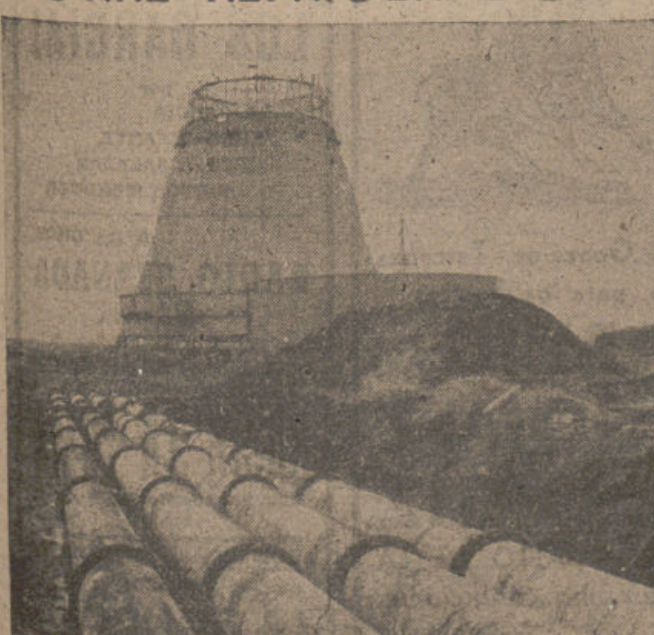
Torre refrigeradora en construcción en la nueva fábrica de productos químicos que la "Shell" está instalando en Thornton. Para aumentar su capacidad de destilación. — (Fot. CALPE)
