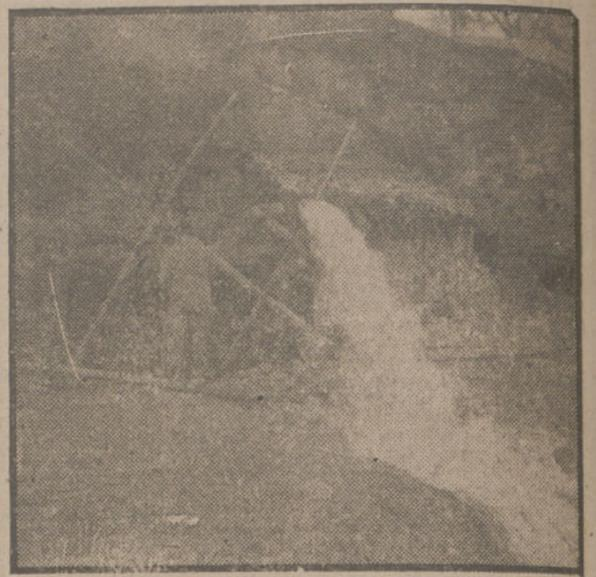
He aquí el pozo construido para la elevación del agua a los terrenos de secano del "Pago del Picón".
