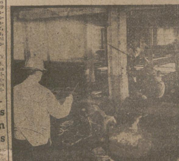
Millares de obreros trabajan activamente en la construcción del futuro palacio de la O. N. U., en Nueva York, que tendrá treinta y nueve pisos. En la "foto" aparecen varios obreros soldando los bloques de acero de la planta baja del gigantesco edificio. (Fot. S. D.)
