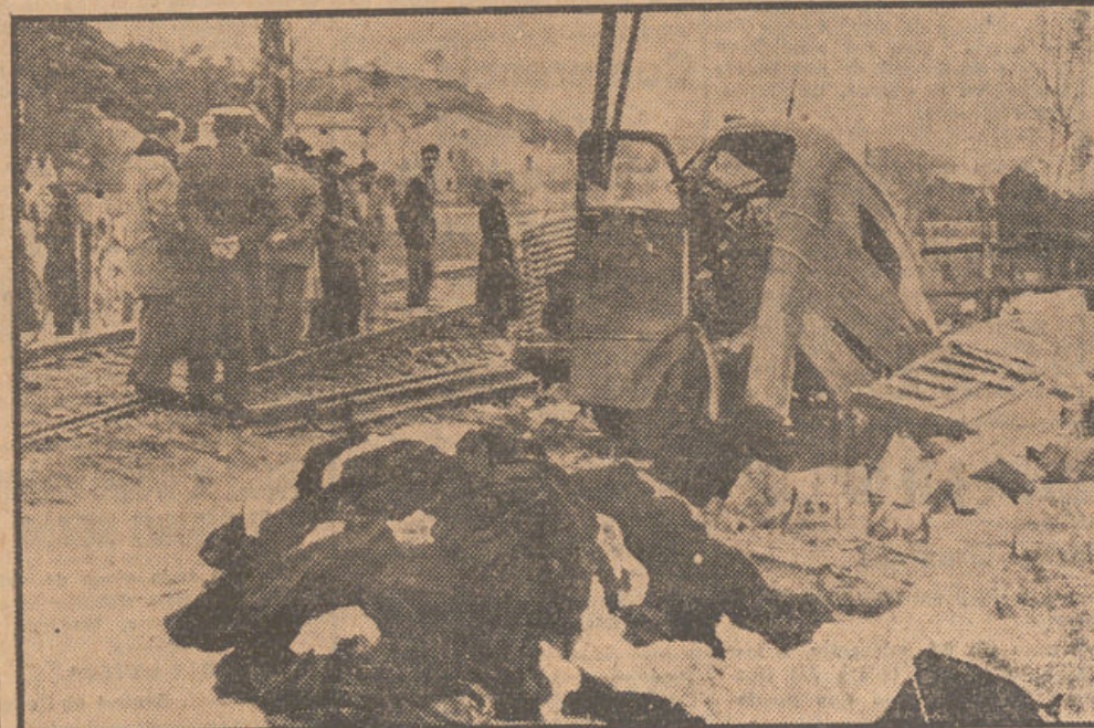
Estado en que quedó el camión cargado de fardos de tejidos que fué arrollado por el correo de Valencia a Barcelona en el paso a nivel de Vinallop, cerca de Tortosa. Una pieza de tela de pana desprendida del camión quedó enredada entre las ruedas de la locomotora, provocando el descarrilamiento del tren, en el que hubo que lamentar dieciocho muertos y treinta y dos heridos. Los ocupantes del camión, que eran tres, también resultaron heridos.—(Fot. CIFRA GRAFICA).
