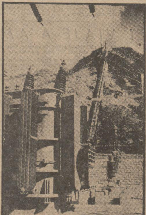
Instalaciones de la central eléctrica de Llesp y tubería de entrada, inauguradas por el Caudillo. Tiene una potencia en turbinas de 17.560 CV. y en alternadores de 12.400 KW a 15.500 KW.
