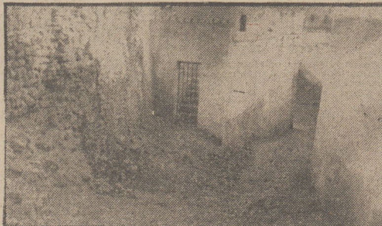
Nuestro fotógrafo ha captado esta calle albaicínera, con cascotes de derrubos y tal, que como tantas otras son constantemente preocupación de los «Amigos de los Cármenes».—(Fot. SANZ.)
