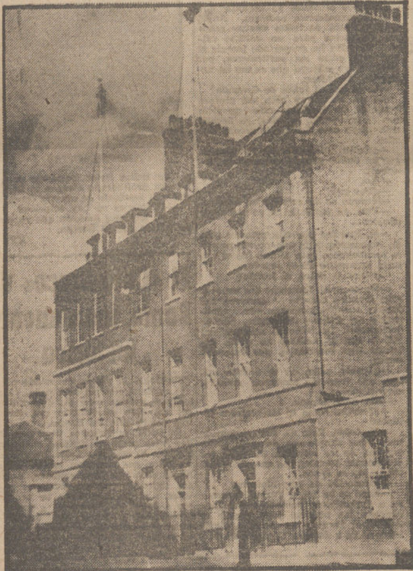
He aquí la fachada principal de la famosa casa número 10 de Downing Street, residencia oficial de Churchill, quien tendrá que desalojarla porque, según dictamen oficial de los peritos, se está hundiendo, no ofreciendo garantía sus cimientos.
