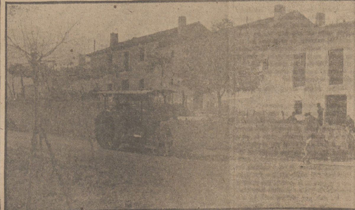
ASPECTO DE LAS OBRAS DE URBANIZACION DE LA CALLE DE LA VICTORIA.
