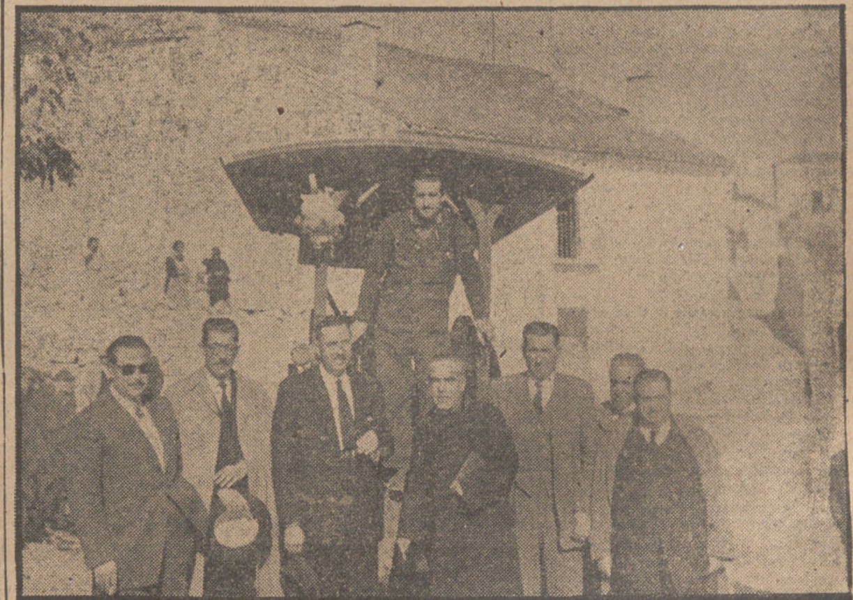
LAS AUTORIDADES LOCALES VISITAN LAS OBRAS DE URBANIZACION.
