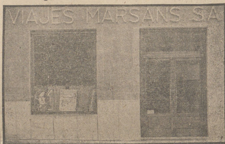
Rachada exterior del edificio en que se hallan instaladas las oficinas de Viajes Marsans S. A.
