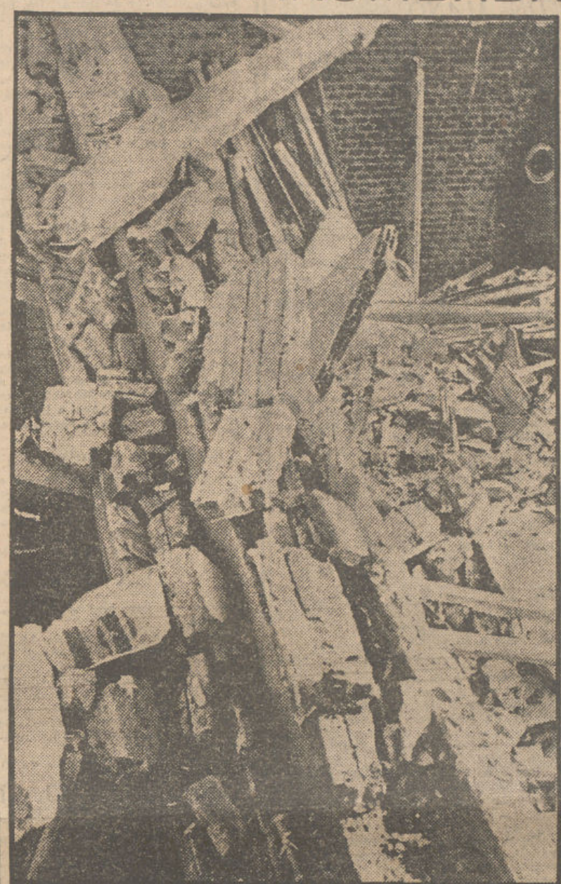
En la calle de San Antonio de Padua, del barrio de Utrera, en Madrid, se derrumbó una casa en construcción, de cuatro plantas. Las primeras noticias dan un triste balance. —(Fot. CONTRERAS).
