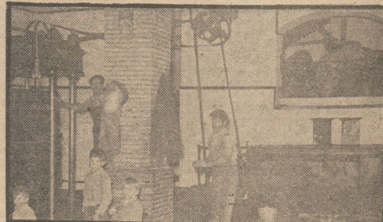
Interior de la fábrica de aceites «La Milagrosa», de Cúllar Baza.
