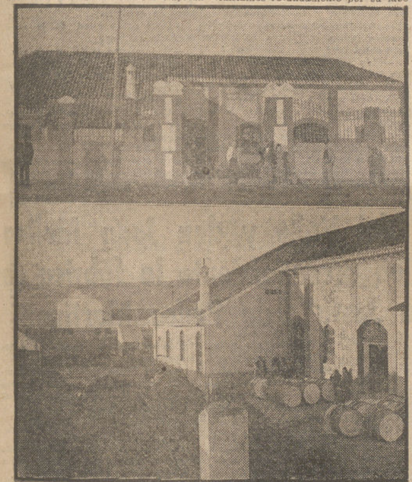
Vistas exterior y patio y muelle de carga de la fábrica de aceites "San Rafael", de Huétor Tájar.
