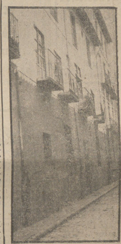
En breve, será demolida la casa número 28 de la calle del Águila, barrio de la Magdalena, en cumplimiento de reciente acuerdo de la Corporación municipal, y en vista de los informes técnicos emitidos sobre el estado del antiguo edificio. La fachada, como puede apreciarse en la fotografía, en la parte correspondiente a la primera planta, se encuentra bastante inclinada, amenazando la seguridad de los vecinos e inmuebles colindantes. (Fot. SANZ).
