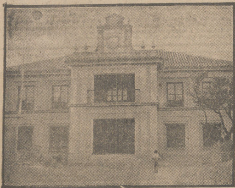
VISTA DEL AYUNTAMIENTO DE ORGIVA
