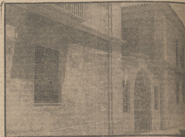
Vista parcial de las casas-viviendas para maestros, de Orgiva
