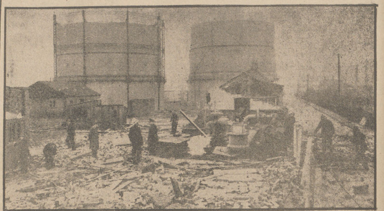
Las instalaciones de Felixstow, en Inglaterra, han sufrido graves desperfectos a consecuencia de una explosión de gas. La catástrofe produjo dos muertos y seis heridos y pérdidas materiales de consideración. Vista parcial de las instalaciones luego del siniestro. (Fot. A. P.)
