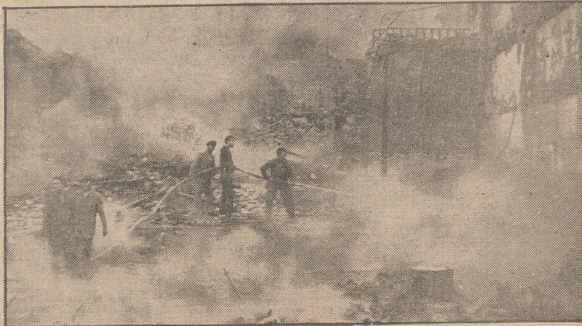
Estado en que quedó el teatro Rodas, de Antequera, destruido por un incendio. — (Fot. GUERRERO).
