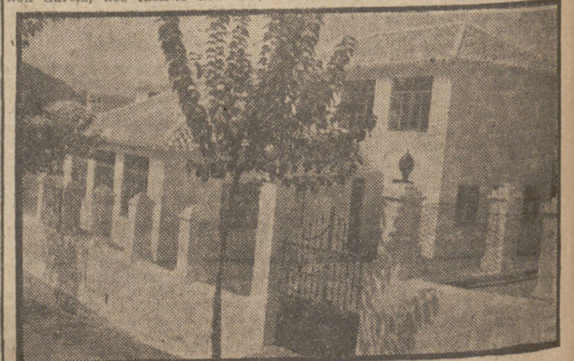
VISTA PARCIAL DEL GRUPO ESCOLAR. —(Fot. ARCHIVO).
