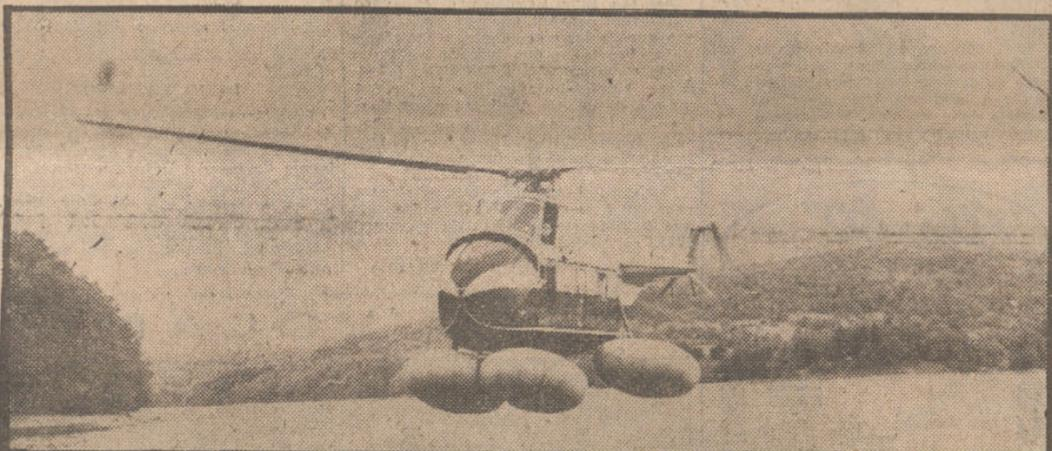
Un helicóptero tipo "Sikorsky S-55", equipado con un nuevo sistema de flotadores neumáticos de 170 libras de peso, que pueden ser puestos en uso eléctricamente en pocos segundos y con los cuales, en caso de necesidad, puede aterrizar en el agua.—(Fot. CIFRA-GRAFICA).
