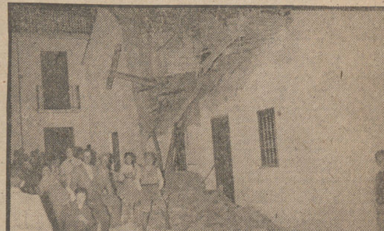
Otra de las casas hundidas en Atarfe a consecuencia del terremoto.—(Fot. SANZ).
