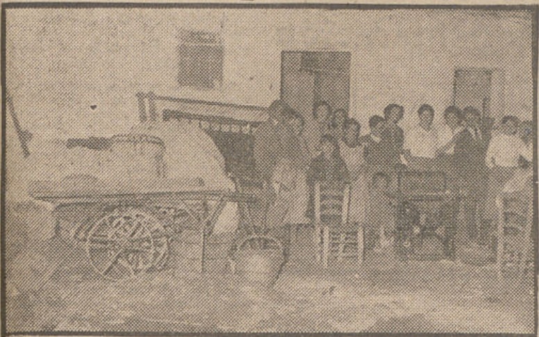
En el barrio de Cartuja la violencia del terremoto ocasiono el hundimiento de un piso de la casa de la calle de Yeseros, 7, causando lesiones mortales a la niña de trece años Teresa Moreno Ruiz, domiciliada en Real de Cartuja, 98, y que falleció en el Hospital a las primeras horas de la madrugada. Aquí vemos a una familia damnificada guardando los humildes enseres salvados de las ruinas de su hogar.—(Fot. SANZ).
