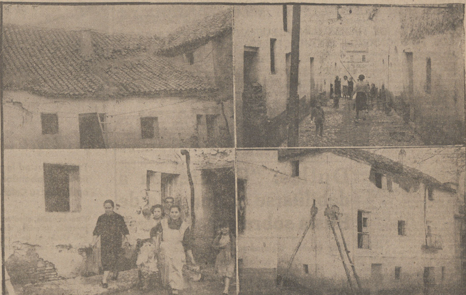
Los servicios técnicos municipales vienen desplegando una eficaz labor, para determinar las viviendas que deben ser desalojadas, como consecuencia de los efectos del terremoto registrado el pasado día 19. Todas las casas que figuran en este reportaje gráfico de Sanz, en el barrio de Cartuja, habrán de ser desalojadas, entre otras muchas, por sus moradores, ya que la estructura de los edificios quedaron gravemente dañadas por el sismo.
