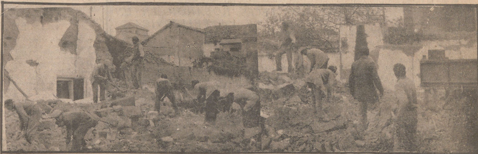
En Albolote, pese al mal tiempo reinante, han comenzado los trabajos preliminares de reconstrucción, desmenuándose las ruinas afectadas, por brigadas de obreros de Regiones Devastadas.—(Fot. SANZ).
