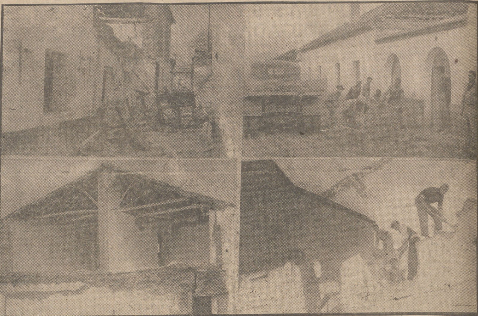
En Albolote comenzaron ayer las tareas de demolición que lleva a su cargo Regiones Devastadas. En la foto superior de la izquierda puede observarse cómo son sacados los enseres de la vivienda en la que perecieron tres personas, a consecuencia del terremoto del día 19. En los otros grabados, otras escenas de las faenas de demolición, que comenzaron por los edificios más afectados.—(Fois. SANZ).
