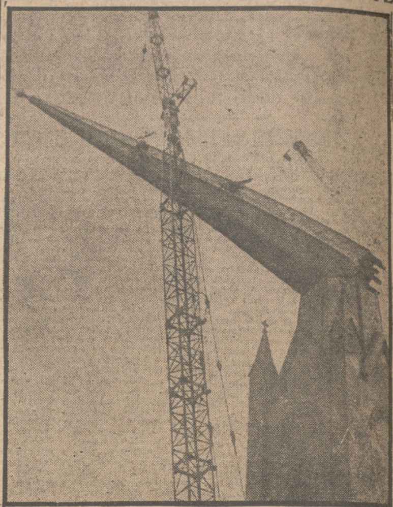
En Troy, localidad del Estado de Nueva York unos operarios proceden a desmontar y a depositar en tierra, con el auxilio de una potente grúa, la cúpula del campanario de la iglesia católica de San Agustín. El remate de la torre se consideraba en peligro desde hace algún tiempo, y los técnicos han considerado que la mejor reparación consiste en cortarla como si fuera la punta de un lápiz. (Fot. A. P.)
