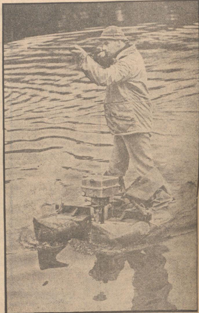
En Inglaterra, el joven Henry Short, apasionado por la caza de aves acuáticas ha ideado este puesto móvil, accionado por un motor, que puede desplazarlo rápidamente, a través de la zona pantanosa. Aquí vemos al cazador probando su complicado invento.—(Fot. A. P.)
