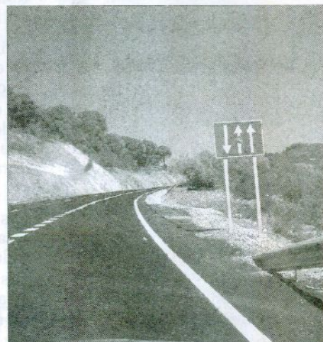
Tramo de la nueva carretera con doble dirección de subida
