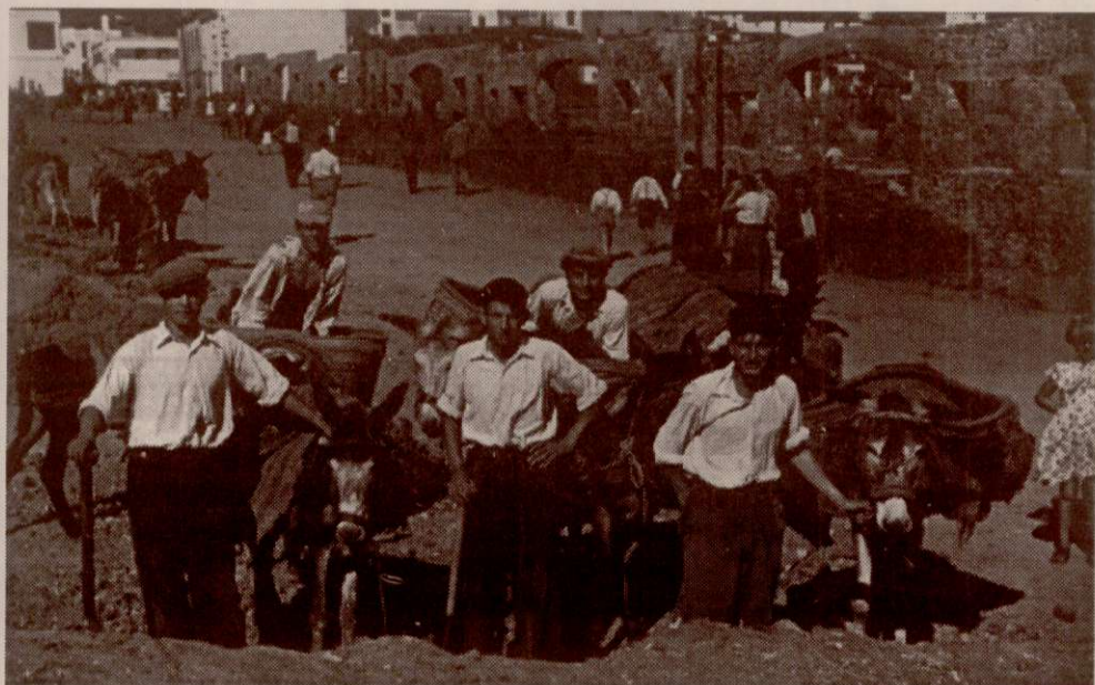
Construcción del paseo de Aroche
