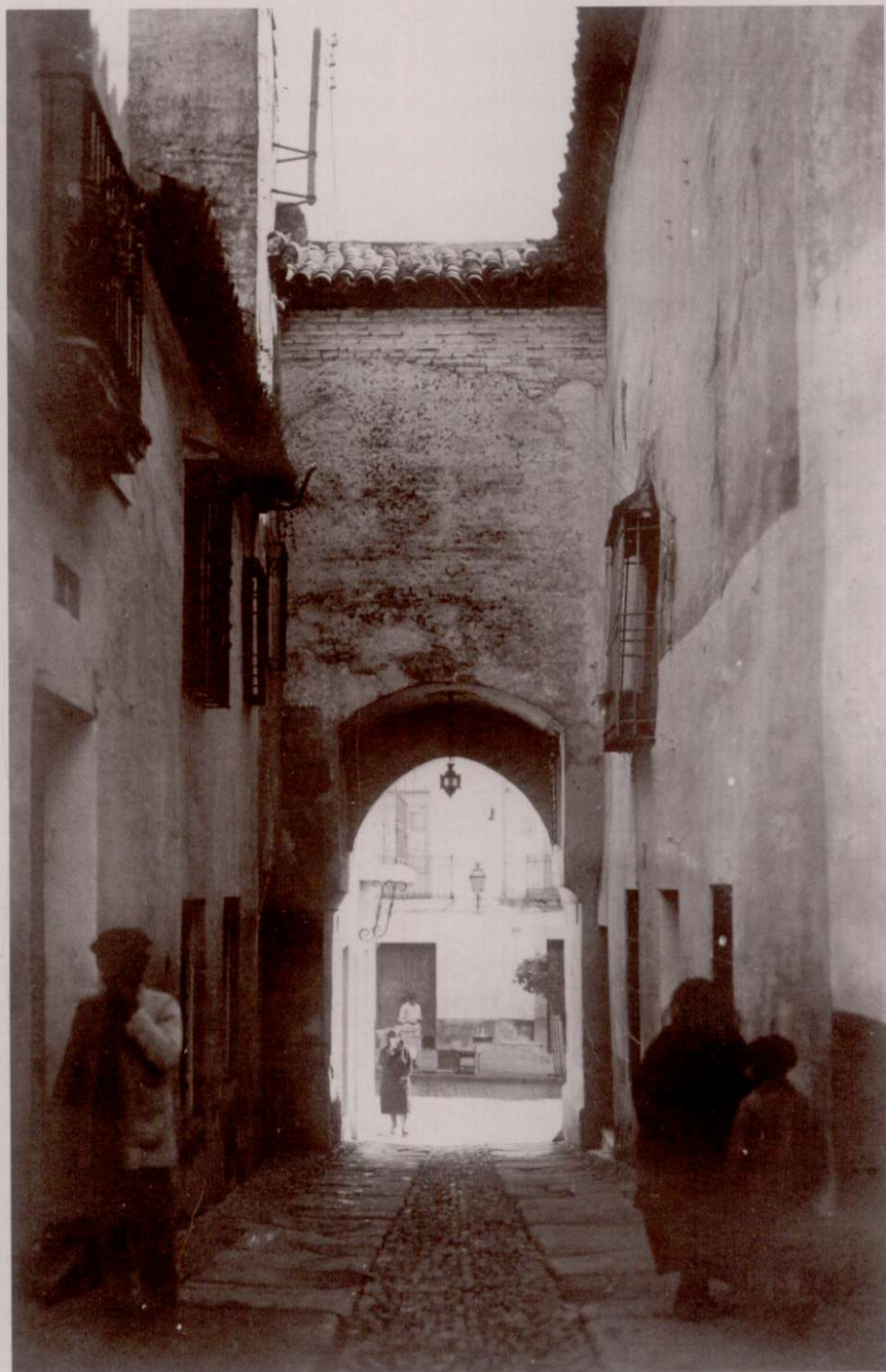
Arco del Portillo (Córdoba)
