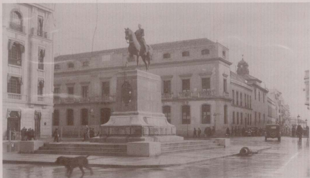
Plaza de las Tendillas (Córdoba)
