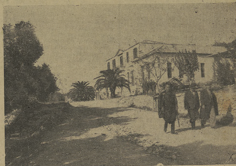
En la fotografía aparece uno de los centros agrícolas de esta isla, instalado por los alemanes. (Foto Trasocéan).
