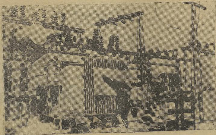
Uno de los aparatos transformadores de la Subestación Eléctrica de Avila, que recibirá y transformará la corriente producida por los Saltos del Alberche. - (Foto Cifra).
