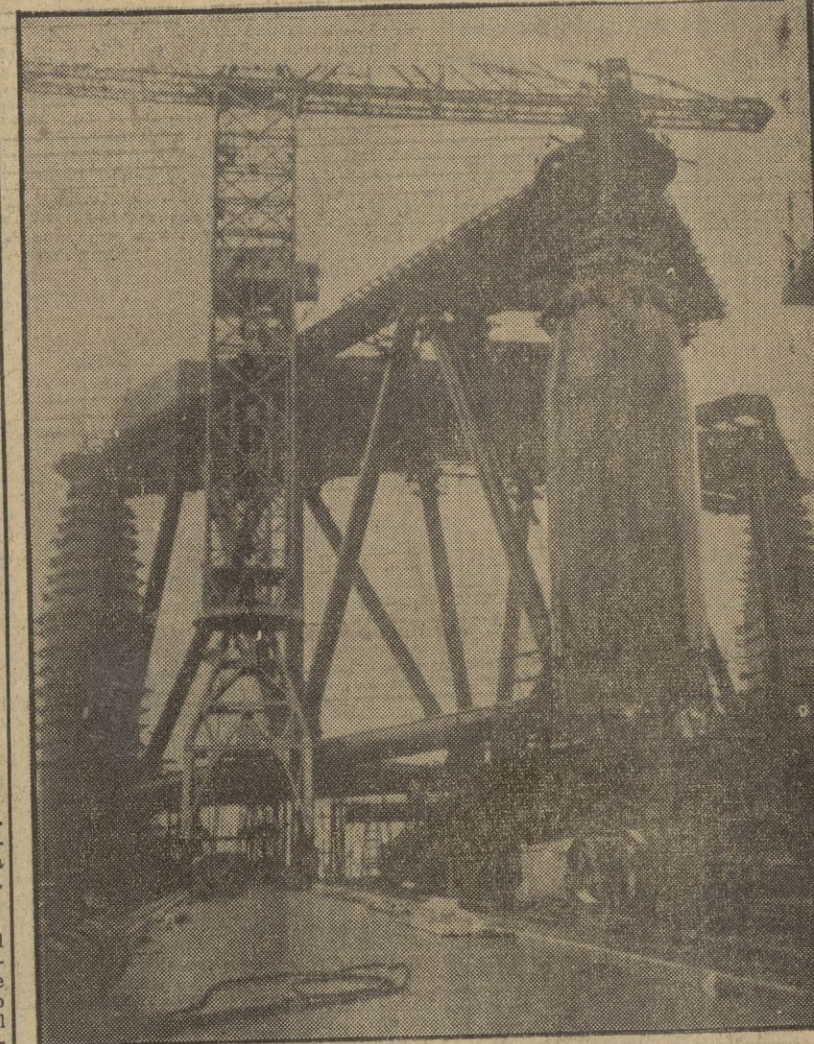
Esta perforadora submarina gigante ocupará el lugar de la "Sea Gem" que se hundió hace poco en el Mar del Norte. Pesa 1.500 toneladas y cuesta tres millones y medio de libras. Puede horadar hasta unos siete kilómetros. — (Foto EUROPA PRESS)
