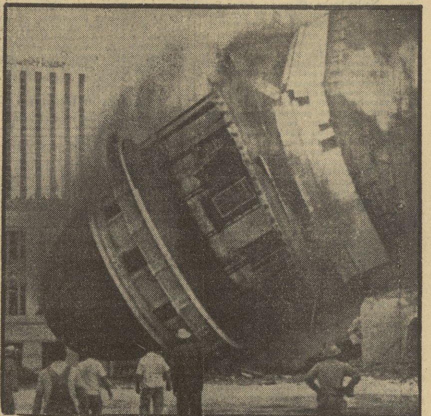
En Fresno (California), la cúpula del antiguo edificio del Tribunal, en el momento de ser derribada. En su lugar se construirá un nuevo y más moderno edificio. — (Foto CIFRA).
