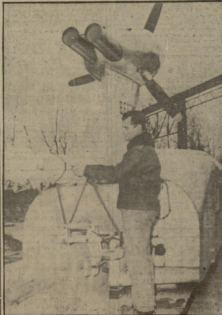
Un técnico realiza los últimos preparativos en el sistema de turbina momentos antes del comienzo de la prueba de ensayo del «aerotren». Este sistema de transporte capaz para 80 pasajeros se desliza por un monocarril de cemento y alcanza una velocidad de 300 kilómetros por hora. — (Telefoto UPI CIFRA)
