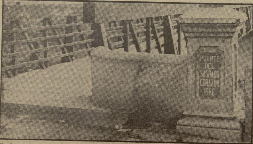
Se dice que las erosiones son producidas por el viento y las lluvias que disminuyen hasta las montañas. Nada tiene de extraño que se haya producido la mordedura que ofrece la foto al pie del pretil en el nuevo puente sobre el mayor de nuestros ríos. — (Foto FERRER)
