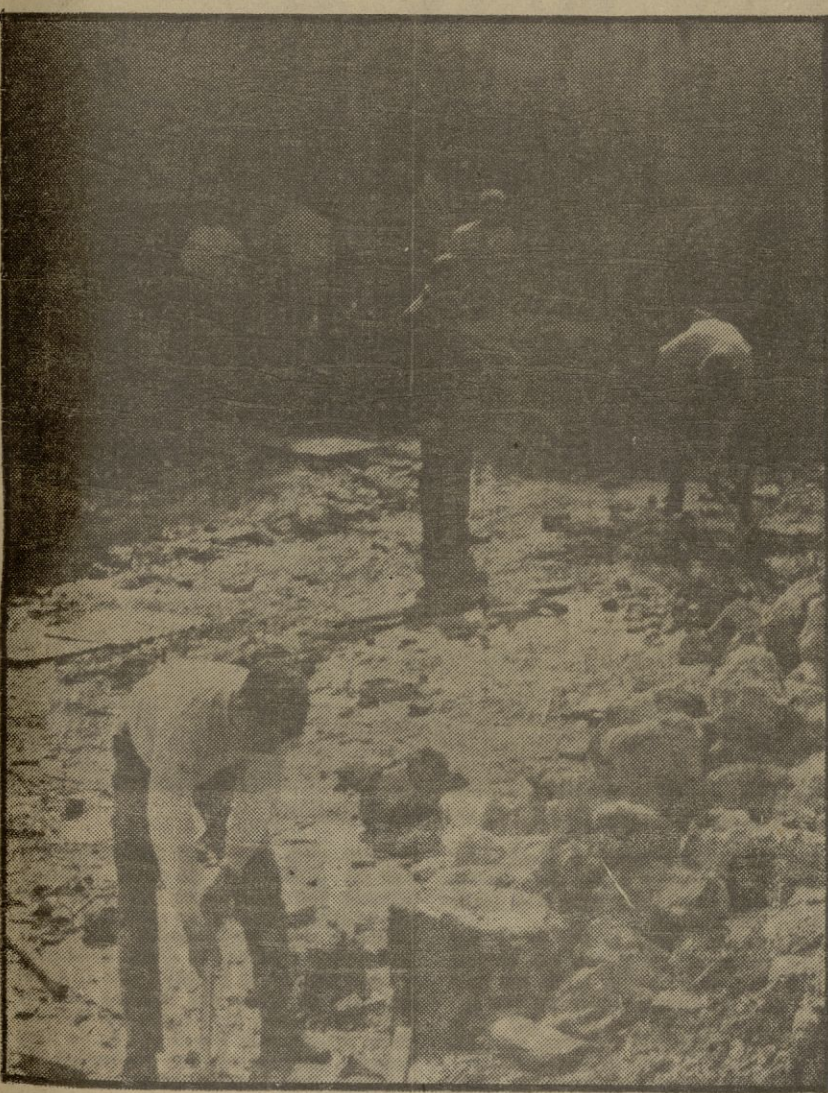
El párroco de Rota, con el capellán comandante y algunos oficiales, soldados y suboficiales de la Base conjunta hispanonorteamericana trabajan con material y maquinaria cedida por las autoridades de la base en la reconstrucción de la parroquia de Nuestra Señora del Carmen. — (Foto EUROPA PRESS)
