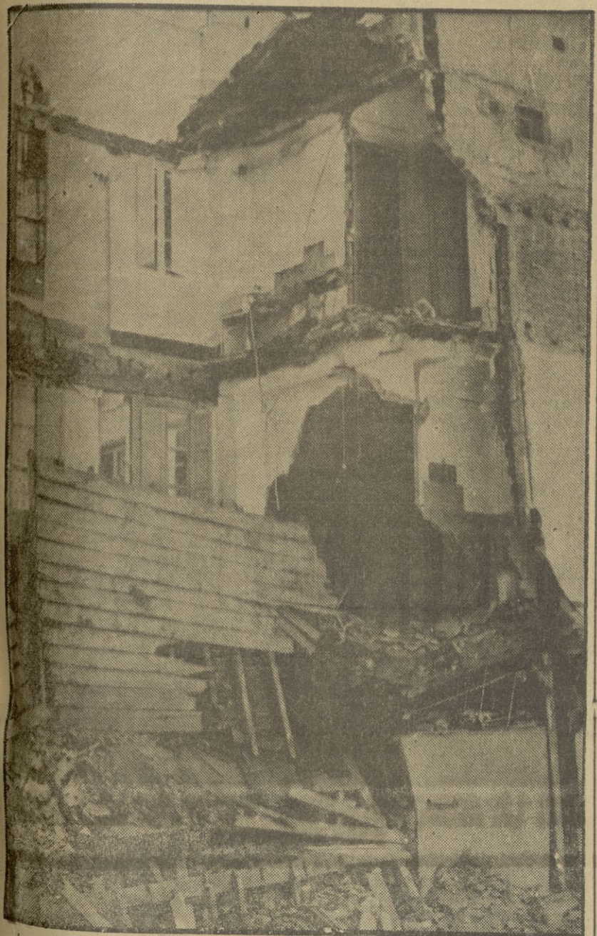
Aspecto que ofrece la casa que en parte se derrumbó ayer en la calle Almona de San Juan de Dios, sin víctimas. El suceso se produjo, al socavar los cimientos en obras que realizan en un solar contiguo. — (Foto FERRER)
