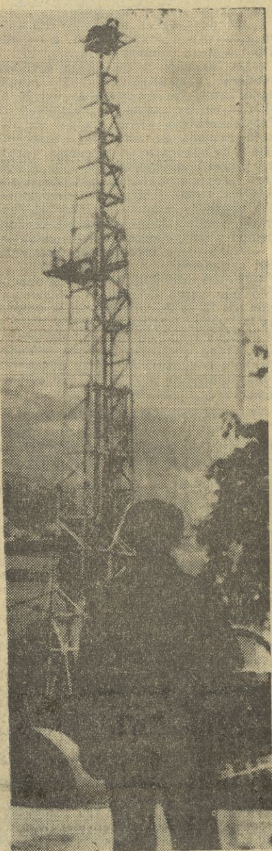
Un equipo completo de prospección petrolífera comenzó los trabajos en busca de petróleo en la provincia de Gijón. Se ha llegado a los quinientos metros. La impresión de los técnicos, según se dice, es favorable. — (Telefoto CIFRA).
