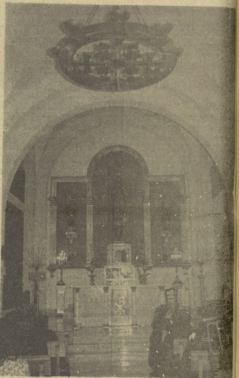
Interior de la capilla. — (Foto FERRER.)
