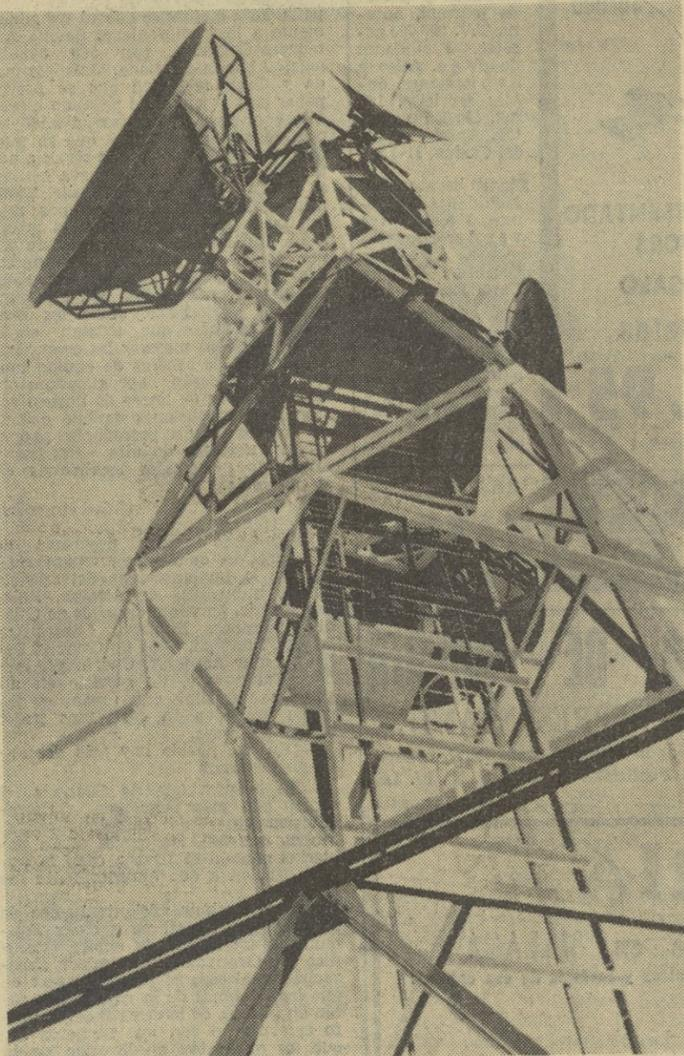
Esta es la torreta metálica instalada en Sierra Elvira y que es soporte de las parábolas para el enlace de microondas de Granada con la red nacional. Funciona ya este sistema con Sevilla y Málaga, a través de Antequera. — (Foto FERRER)
