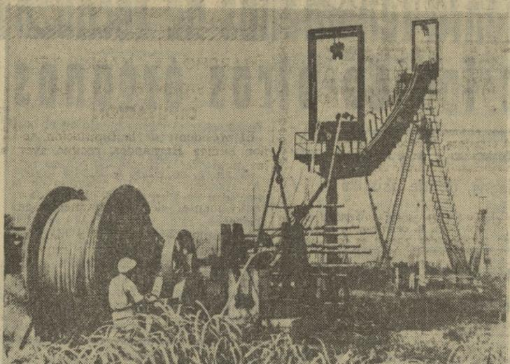
Un nuevo método de suspensión de puentes se comprueba por vez primera en el Japón. El método consiste en un grueso cable entre dos «puertas» en altura para sujetar el puente que va suspendido. 158 metros de puente cuestan por este método unos 140.000 dólares. — (Foto EUROPA PRESS)
