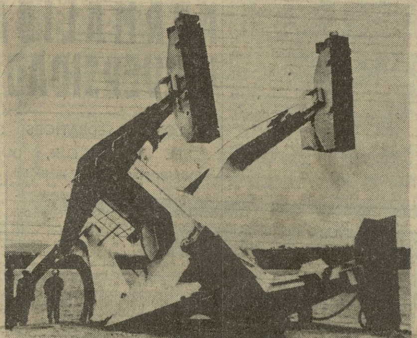
Una grúa de quince toneladas, que había sido recientemente instalada en el puerto ferrolano, aparece partida por la mitad y derrumbada sobre el muelle, tras el fuerte vendaval. La fuerza de los vientos osciló entre los ciento y cinco kilómetros por hora. — (Foto EUROPA PRESS)
