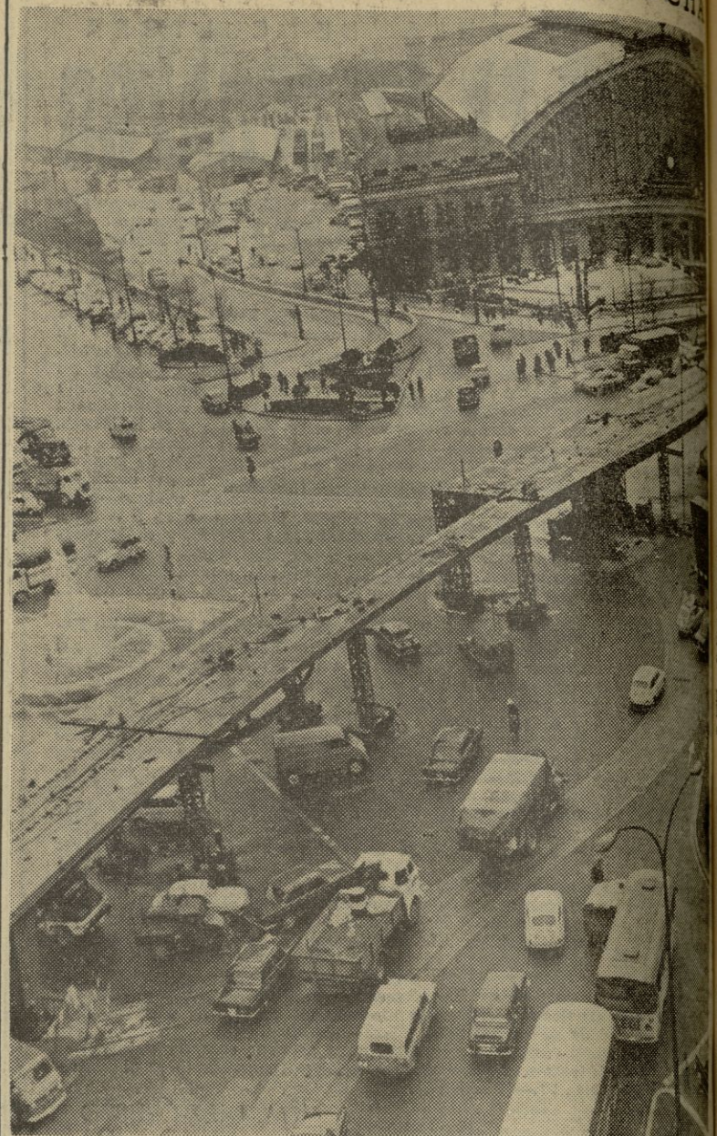
Una vista aérea de la Glorieta de Carlos V (Atocha), de Madrid, en el momento de la colocación del último tramo del cruce aéreo que une el Paseo del Prado con el Paseo de Santa María de la Cabeza. — (Foto EUROPA PRESS)
