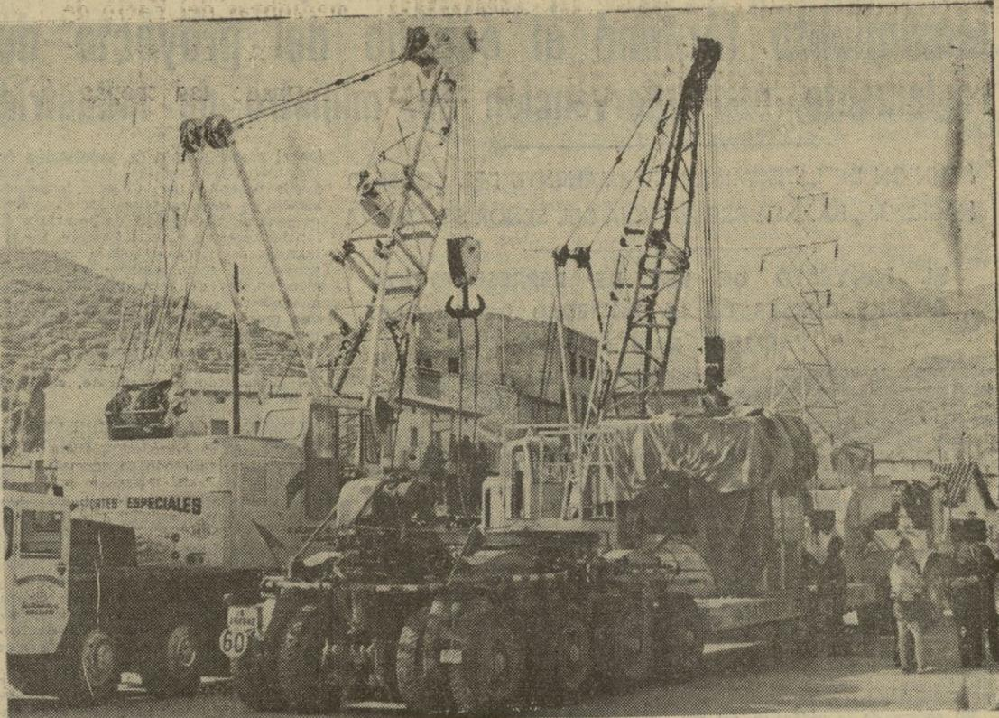
Un momento del transporte desde la estación de ferrocarril de Pobla de Segur (Lérida), hasta la central subterránea de Tabescan, de un alternador de 140 toneladas de peso. Dicha central alcanzará una vez terminada una potencia de 175.000 kilowatios/hora. — (Foto EUROPA PRESS)
