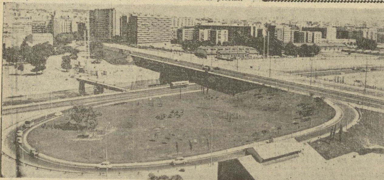
Ayer, día 11, fueron inauguradas oficialmente las grandes obras de los accesos a la capital de España por las seis carreteras radiales. Dicha inauguración estuvo presidida por las altas jerarquías de la capital. En la foto, el puente sobre el río Manzanares y avenidas marginales correspondientes al complejo viario del gran eje que da comienzo en Fuencarral para seguir por Santa María de la Cabeza hacia la carretera de Andalucía y carretera de Toledo y avenidas marginales de la futura autopista que con la proyectada avenida de la Paz, circularán la capital. — (Foto CIFRA GRAFICA)
